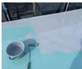
例) 屋上ウレタン防水工事
